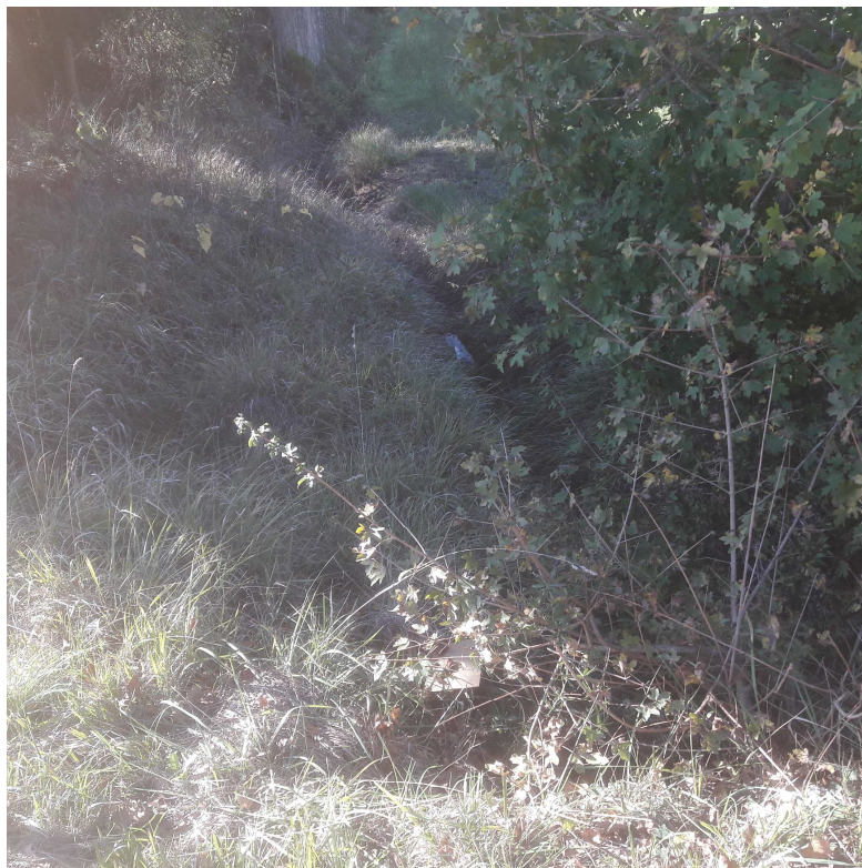
foto 3 _ Fosso esistente lato cimitero comune
