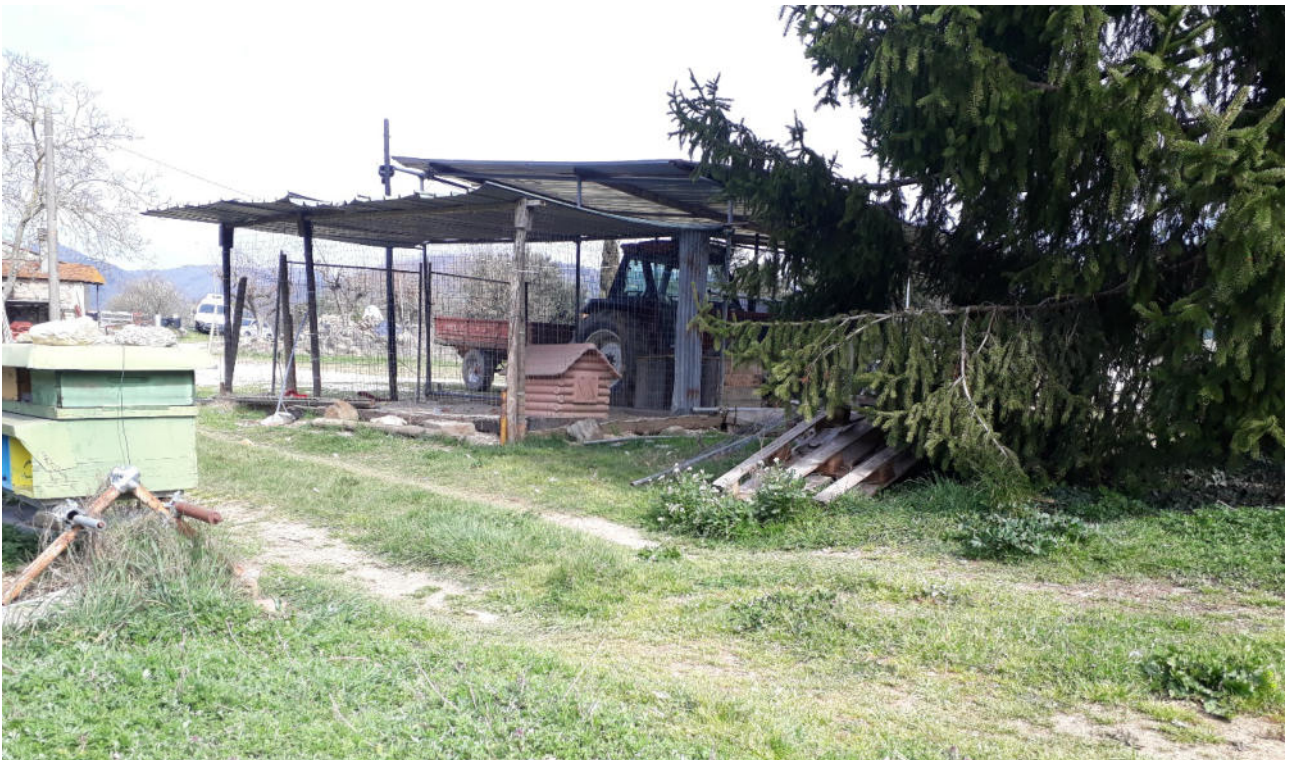
Foto n. 10 – Vista dell'area in cui il tombino esistente (da adeguare) attraversa la strada sterrata per scaricare nell'Arno. L'area è interna al vincolo paesaggistico.
