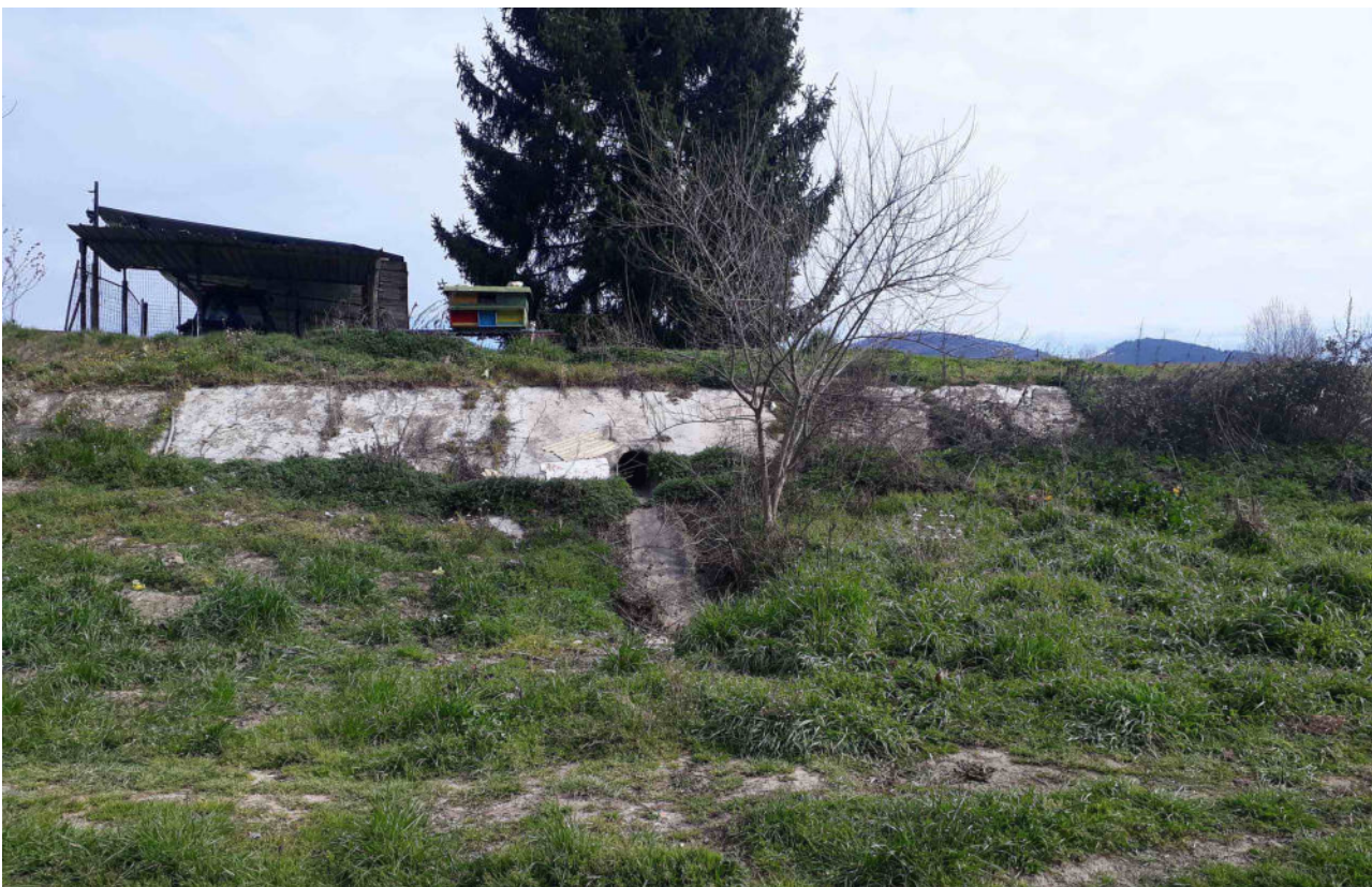
Foto n. 12 – Vista del tombino (da adeguare) che scarica nella golena nell’Arno. Visibile il rivestimento in calcestruzzo del ciglio di scarpata. L’area è interna al vincolo paesaggistico.
