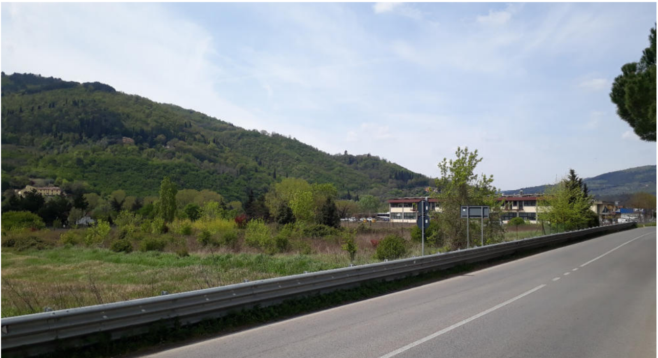
Foto n. 1 – Vista dell'area d'intervento dalla S.S. 67 Tosco Romagnola in direzione della località Sieci. In primo piano il fosso, sullo sfondo le colline boscate in riva sinistra d'Arno. Per la grande differenza di quota l'alveo del fiume non è visibile. L'area è esterna al vincolo paesaggistico.
