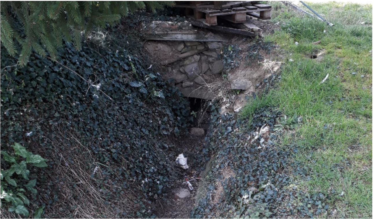
Foto n. 9 – Vista del fosso e del tombino esistente da adeguare. L'area è interna al vincolo paesaggistico.
