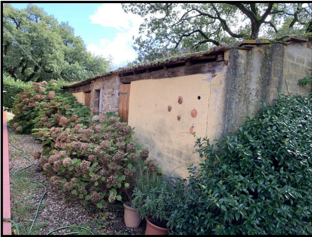
Foto annesso lato rivolto verso la casa colonica
