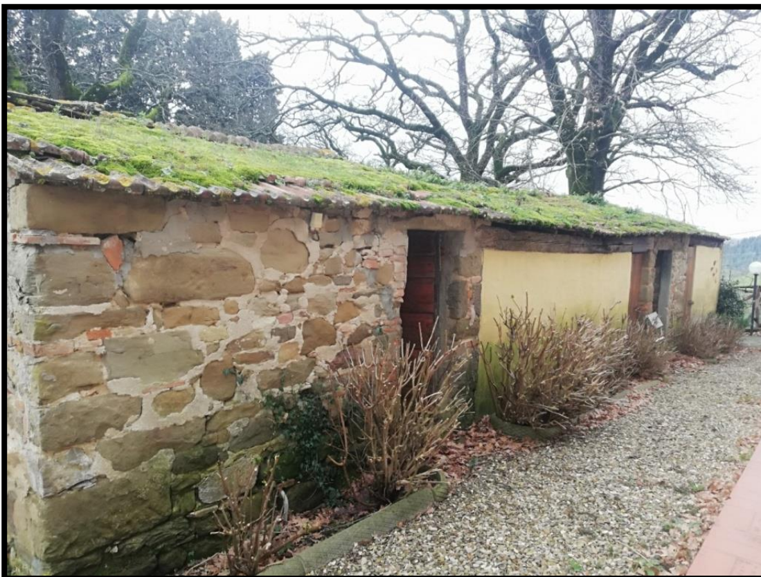
Foto lato rivolto verso la casa colonica
