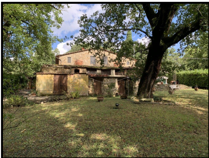
Fig. 11 Prospetto a valle
